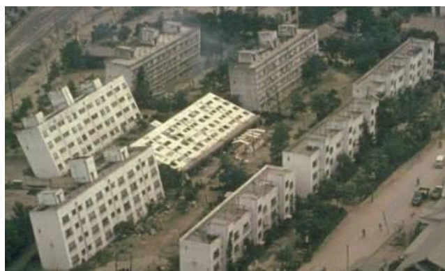
Efectes d'un terratrèmol en edificis sobre un sòl tou
