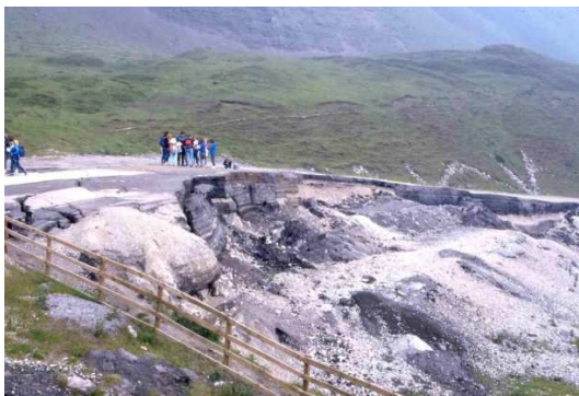
Mam Tor – den gamle veien ødelagt av skred og har vært ubrukelig siden 1977. (Foto: Peter Kennett).
