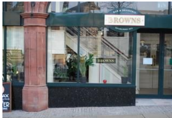
Bygningsstein i byen – rød sandstein og granitt er brukt i inngangspartiet på en kafe. Gulvet består av granitt og polert sandstein, St Paul's Parade, Sheffield (Foto: Peter Kennett)
