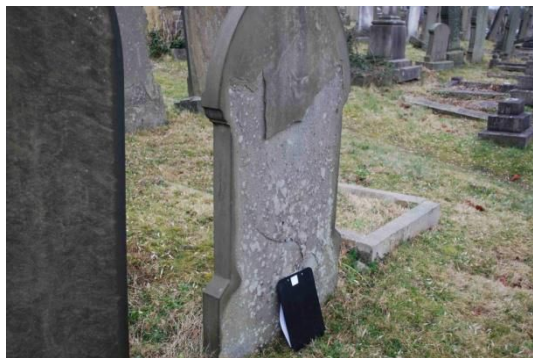
Avskalling på den ene siden av en gravstøtte i sandstein (den andre siden er upåvirket). (Ecclesall Churchyard, Sheffield)
