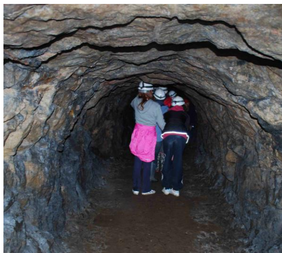
Túnel sense suport excavat en calcàries per miners del coure el 1804 (Totes les fotos: Peter Kennett)
