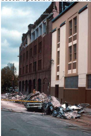
Cotxes esclafats per la caiguda de materials que va matar 5 persones que sortien de treballar. Terratrèmol de Loma Prieta earthquake, 17 Oct. 1989. (De la US Geological Survey Photographic Library a: http://libraryphoto.cr.usgs.gov Diapositiva 1-1 USGS Open File Report 90-547)
