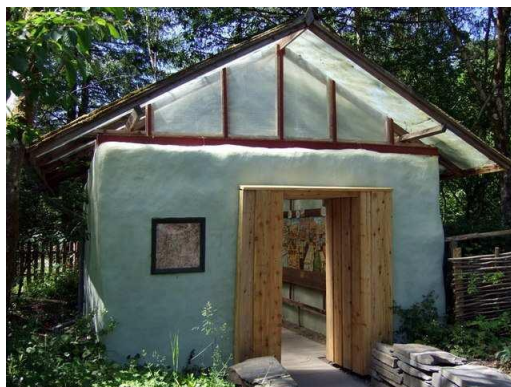
Casa de bales de palla, Centre d'Alternatives Tecnològiques Machynlleth, Gal·les © amb llicència per ser reproduït sota Llicència Creative Commons
