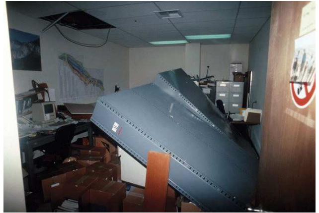
Librerie non fissate al muro cadute durante il terremoto di Loma Prieta, 17 ottobre 1989, nel quartier generale del settore di indagine geologica degli Stati Uniti a Menlo psark, California. Diapositiva VI-1 (Dalla Libreria Fotografica del US Geological Surveya: diapositiva VI -1 USGS Open File Report 90-547)
