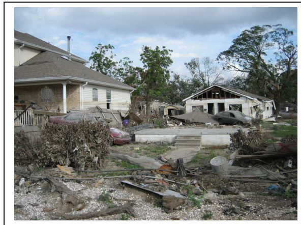
New Orleans dopo l'uragano Katrina: l'alluvione ha danneggiato il quartiere del West End, Bellaire Street, vicino alla falla nell'argine del 17th Street Canal. L'alluvione ha travolto le auto e ha divelto una casa dalle fondamenta spostandola di mezzo isolato.
